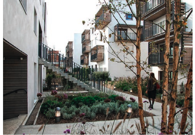
Archikubik Urbanistes et Architectes Quartier Carnot-Verillot, Ivry-sur-Seine
