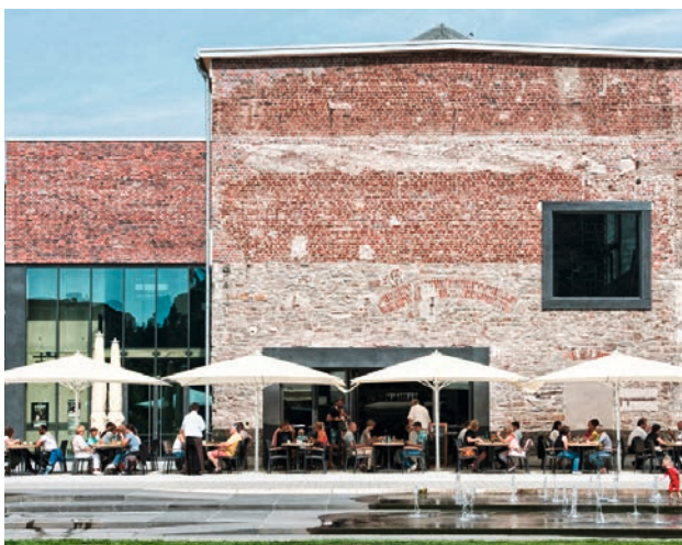
Umbau Produktionshalle, Gummertsbach Heinrich Böll
